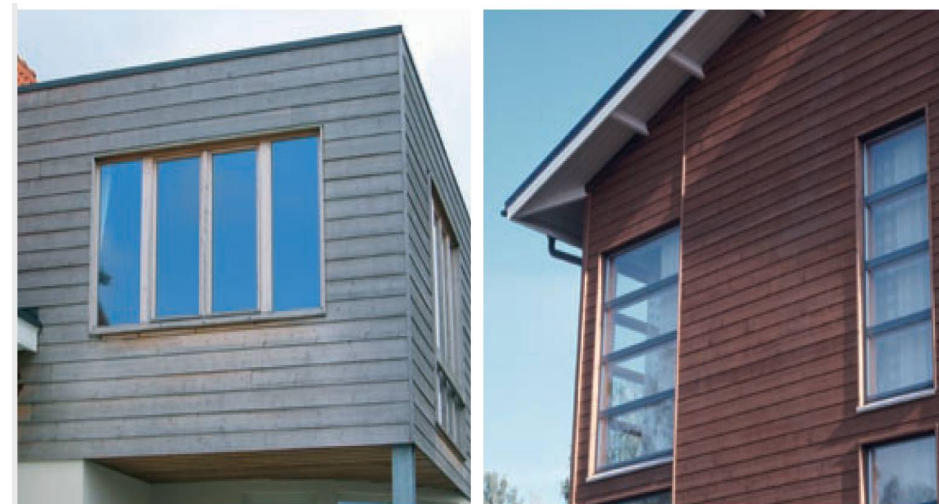
Revestimento Thermowood após três anos de exposição aos agentes atmosféricos (com e sem pintura)
